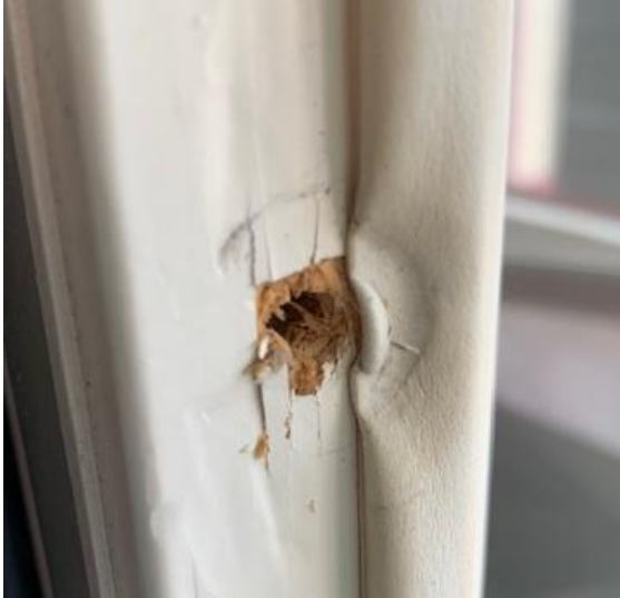
Hålet i innerfönstret efter borttagning av den gamla handelen.
