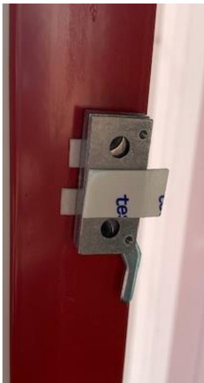
Koppelhaken under förmontering med dubbelhäftande tejp inför markering av platser för borrhålen.
