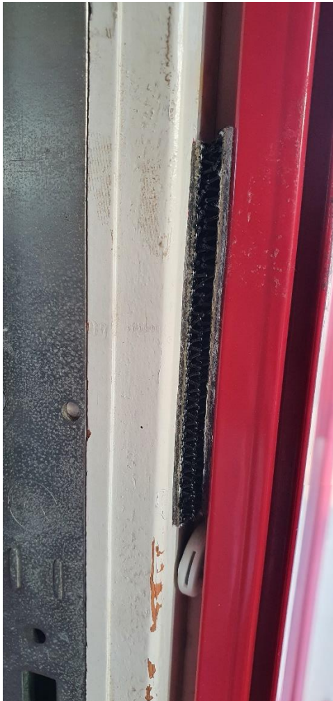
Reparation med självhäftande kardborrband placerat bredvid den trasiga koppelhaken.
