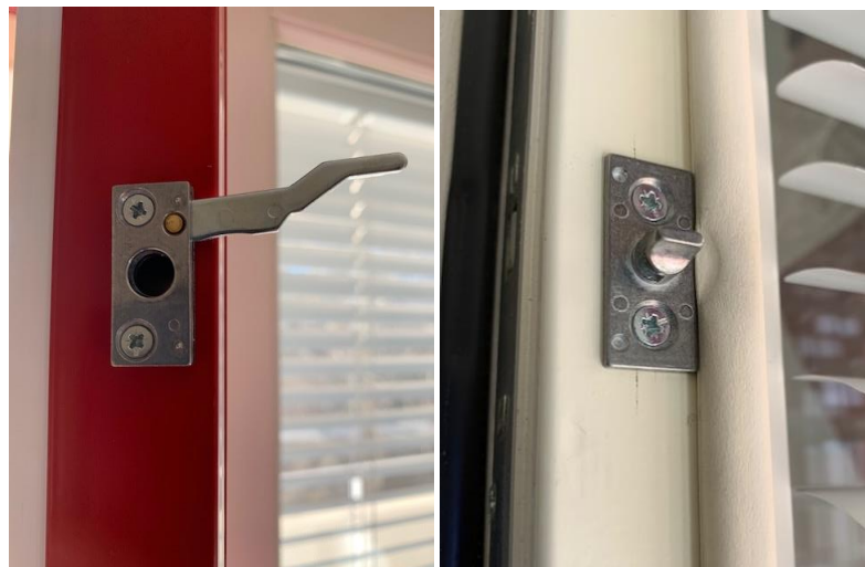
Koppelhakens båda delar fastskruvade på respektive plats.
